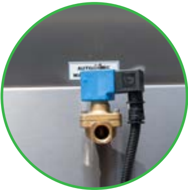
ÉLECTROVANNE DE REMPLISSAGE
