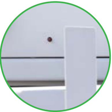
SENSORE DI APERTURA PORTA
